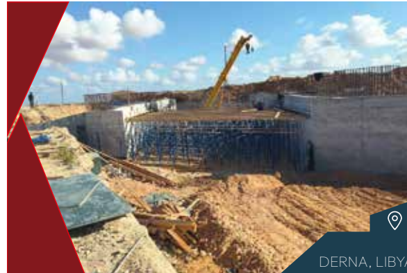
DERNA BENGHAZI BRIDGE (BRIDGE 2) كباري طريق درنة -بنغازي (كوبري ٢)
