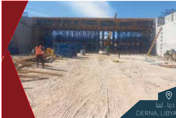
DERNA BENGHAZI BRIDGE (BRIDGE 1) كباري طريق درنة -بنغازي (كوبري ١)
