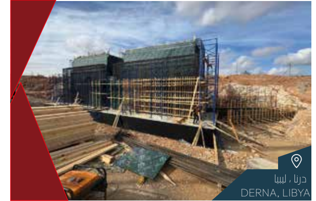
DERNA BENGHAZI BRIDGE (BRIDGE 3) كباري طريق درنة -بنغازي (كوبري ٣)
